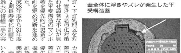
蓋受ブロックが損傷しガタツキが発生した平受構造蓋
