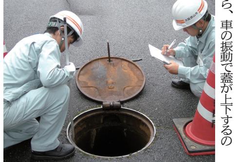
マンホール蓋の調査点検の様子
