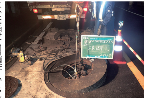
円形カッター工法で受枠ごと交換
