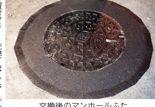
交換後のマンホールふた
