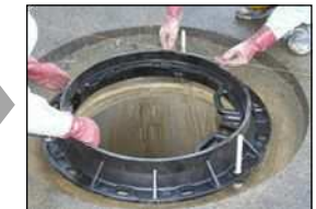
マンホール上部壁とマンホール蓋の緊結による横ズレ防止
