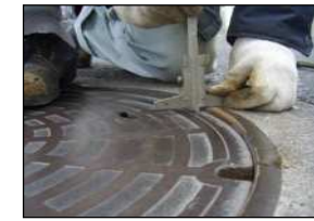
マンホール蓋及び公共汚水枡蓋の点検・調査
