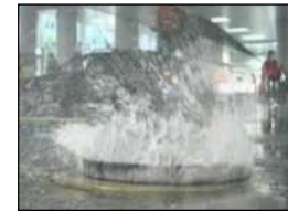
浮上・飛散するマンホール蓋
