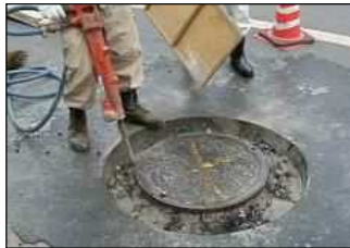
マンホール蓋の改築
