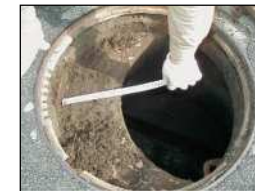
ボルト無緊結の古いタイプのマンホール蓋の横ズレ
