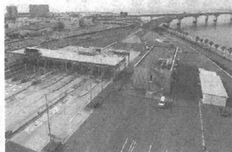
前田建設が運営受託した愛知県の有料道路
