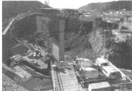
2016年の熊本地震で崩落した阿蘇大橋の再建現場。21年3月に新たな橋が開通するまで5年近くを要した
