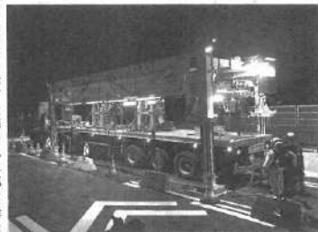
大林組とNEXCO中日本は高速道路の1車線だけを規制して床版を取り換えた
