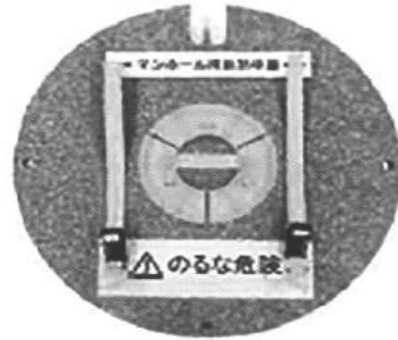
写真-3 断熱中蓋（後付けタイプ）
