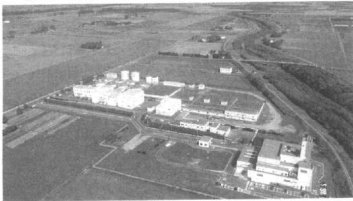
資源循環・有効利用の取組みに荣誉（奥から恵庭下水終末処理場、恵庭市生ゴミ・し尿処理場、恵庭市焼却施設）
