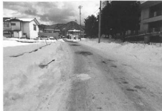
写真-1 マンホール蓋上の雪が融けて段差ができた状態
