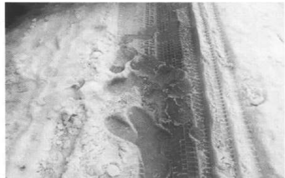
写真-5 断熱中蓋対策後（段差の発生なし）
