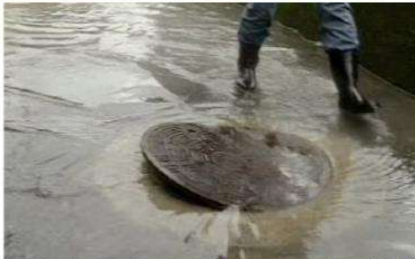
図2 フタが外れかかったマンホールに向かって水が流れ込む様子 (日本グラウンドマンホール工業会提供)
