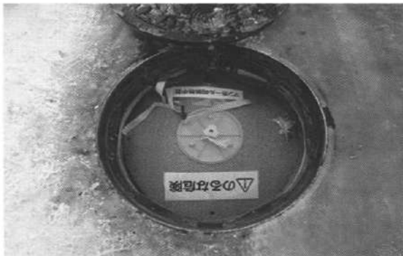
写真-4 断熱中蓋（後付け）取付け状況
