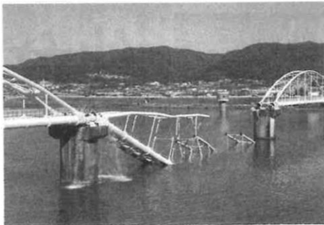
橋体の中央部が崩落した六十谷水管橋
