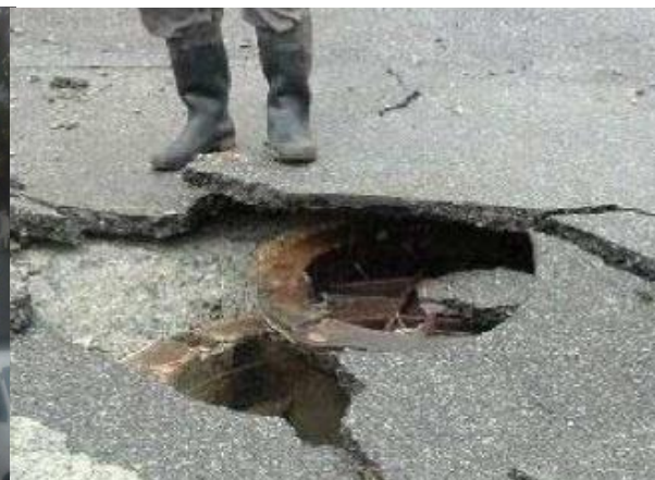
内圧による蓋の浮上飛散 ⇒ 事故
