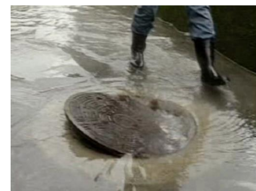
冠水時の蓋外れ ⇒ 転落事故
