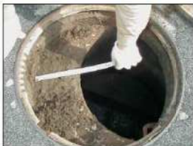
ボルト無緊結の古いタイプのマンホール蓋の横ズレ
