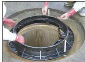
マンホール上部壁とマンホール蓋の緊結による横ズレ防止
