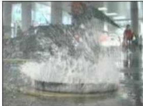
浮上・飛散するマンホール蓋
